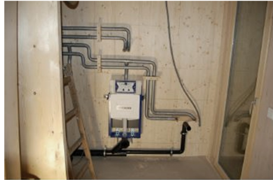
Abbildung 62: Leitungsführung Sanitär
