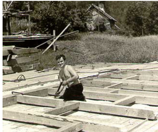
Abbildung 17: Arbeiten am Schnürboden, Hans Staiger
