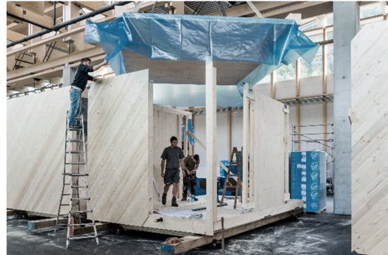
Abbildung 25: Zusammenbau Raummodul
