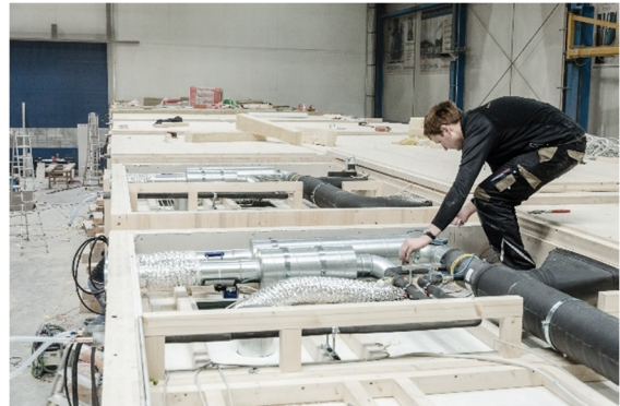
Abbildung 65: Leitungsführung Lüftung, Sanitär
