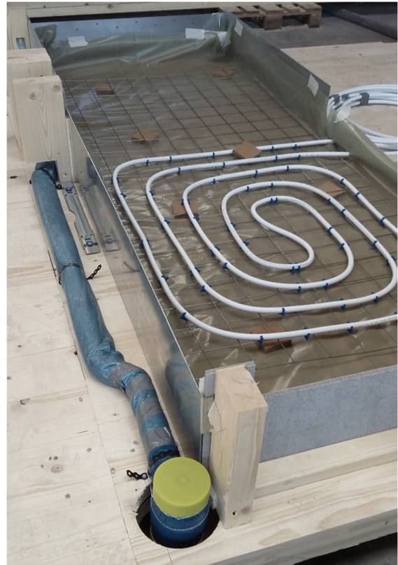
Abbildung 67: Leitungsführung Fußbodenheizung
