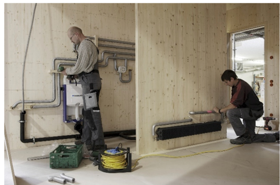
Abbildung 66: Leitungsführung Heizung, Sanitär
