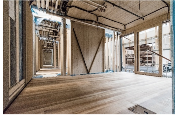
Abbildung 28: Innenausbau mit Leitungsführung
