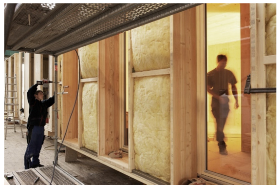
Abbildung 20: Arbeiten an der Fassade
