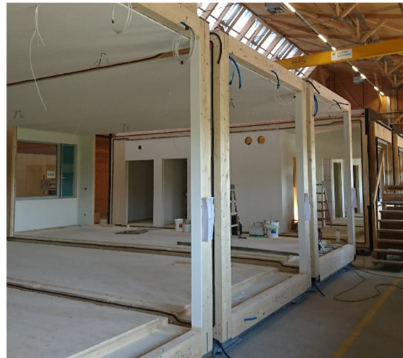
Abbildung 4: Modulfertigung, Blumer-Lehmann AG / Schweiz
