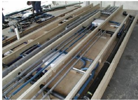
Abbildung 63: Vorgefertigter Installationsschacht
