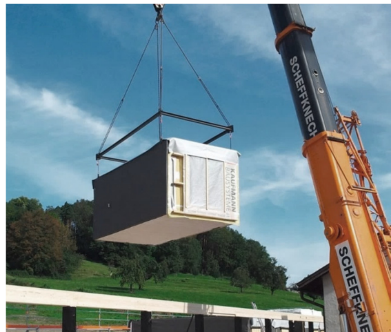
Abbildung 5: Montage der Module, Kaufmann Bausysteme, Reuthe, Vorarlberg
