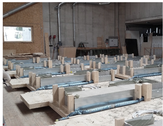
Abbildung 68: Fertigung Bodenelemente Nasszellen für Hotel Revier, Lenzerheide, Schweiz
