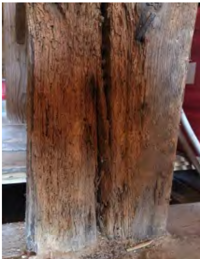
Abb 192 Insektenbefall von Holzstütze
