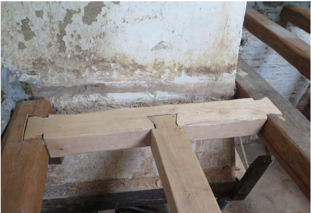
Abb 193 Auswechslung von Holzbalken
