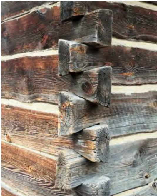
Abb 78 Schwalbenschwanzstrick
