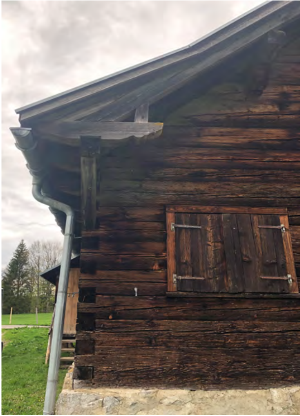
Abb 93 Aufschiebling
