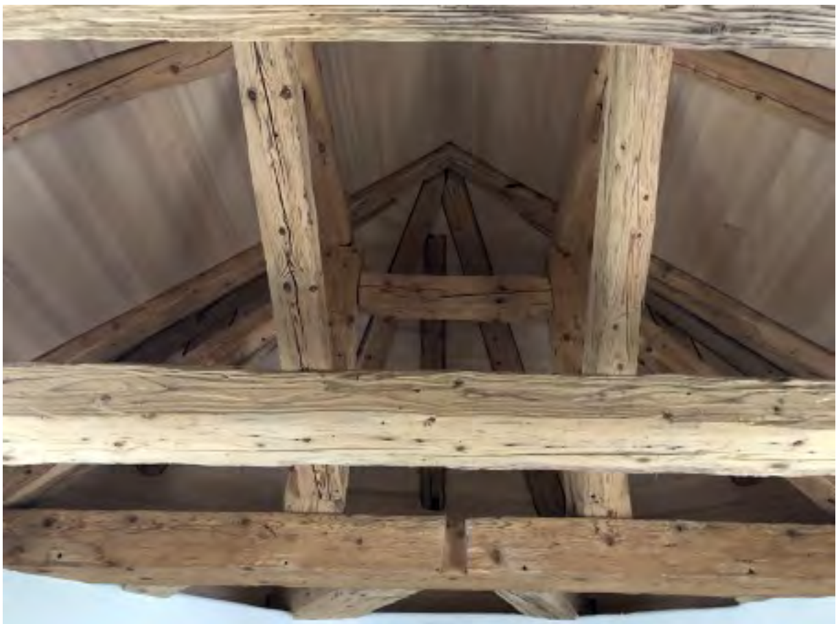
Abb 190 Sanierter und erneuerter Kapellendachstuhl
