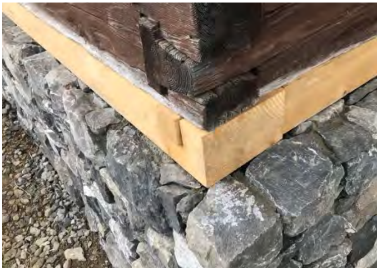
Abb 196 Schwellholz unter bestehenden Blockbau
