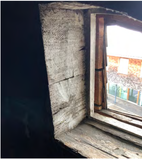
Abb 207 Foto Außenwand Bestand
