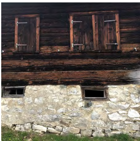
Abb 191 Blockbau auf Natursteinmauerwerk
