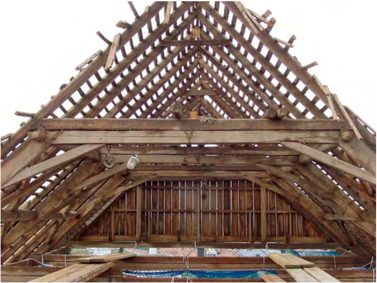
Abb 88 Scheune mit liegendem Stuhl
