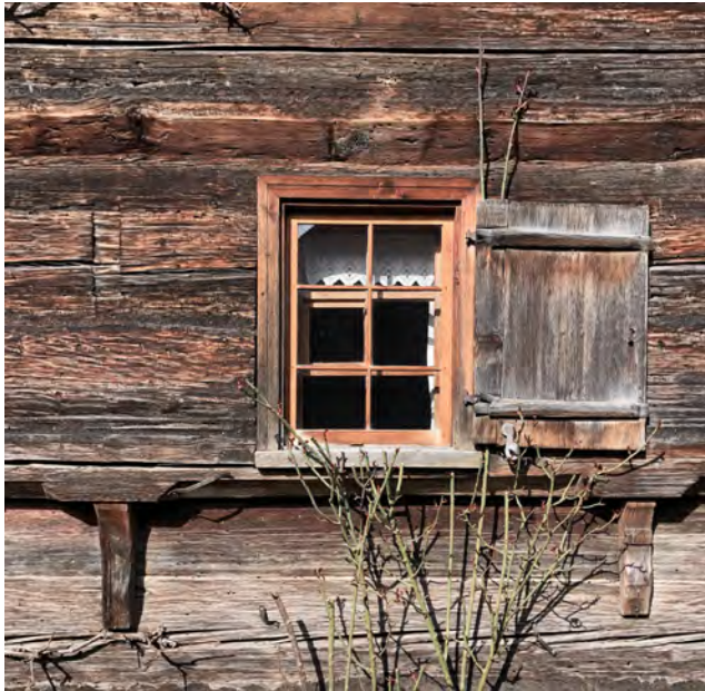
Abb 42 Fenster Haus Hub
