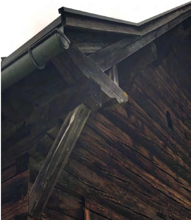
Abb 94 Aufschiebling
