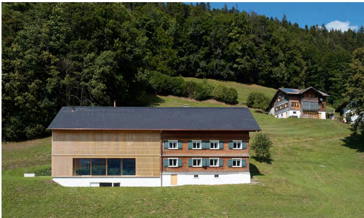
Abb 100 Südansicht Haus W
