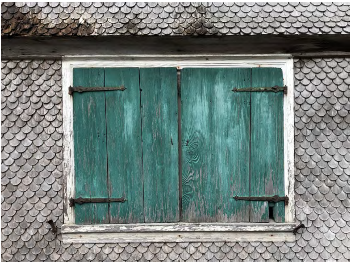
Äbb 51 geschlossener Fensterladen
